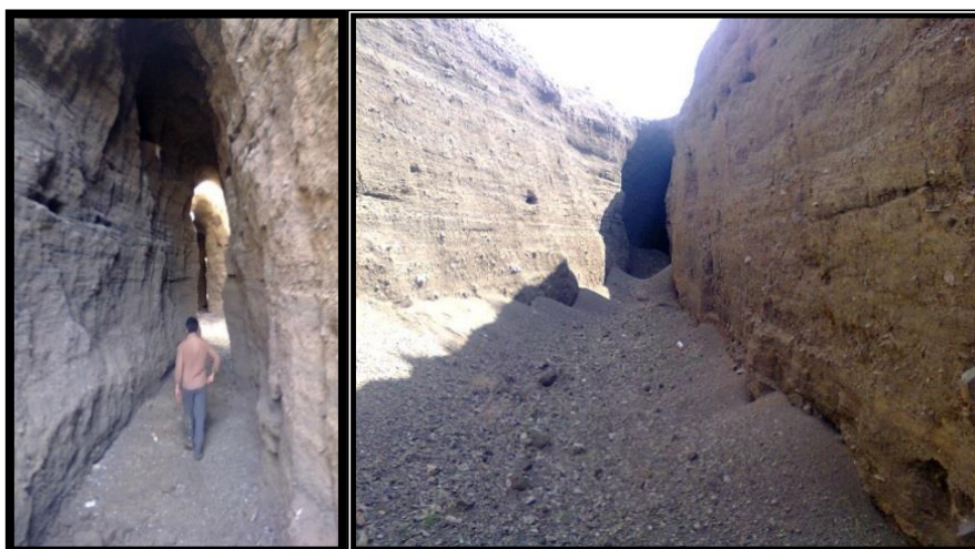
شکل (۵): تصویر تخریب آبروانه Fig (5): Demolition of Abravaneh
