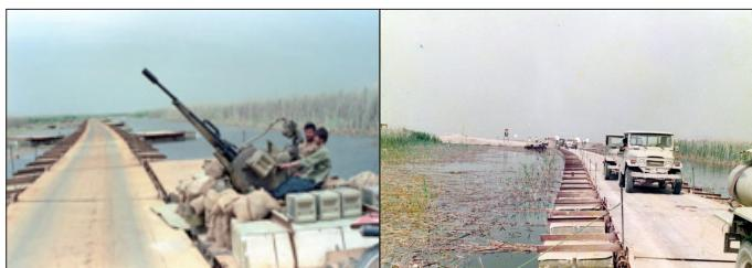
نسل اول پل خضری نیز با لودرهایی که از دو ساحل با سیم بکسل به پل وصل بوده، جابه‌جا می‌شد. اما در نسل بعدی پل خضری، با گذاشتن یک تراکتور (بدون چرخ) روی پل، پل خضری مشغول فعالیت شد.
