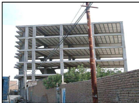
تصویر ۳: واحد مسکونی ۵ طبقه در روستای سلطان‌آباد
