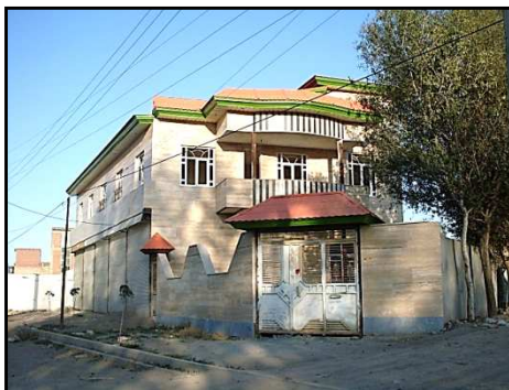
تصویر ۴: واحد مسکونی با کاربری مسکونی - تجاری در روستای آقبلاغ آقاجان
