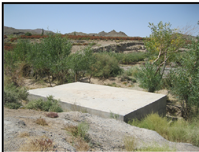
شکل ۲: نمای کلی خانه تقسیم آب
