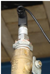
شکل ۳ - سنسور فشار. شکل ۴ - نصب سنسور فشار.
