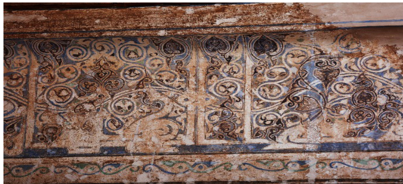
تصویر ۲۹- بخشی از کتیبه بنای ارسلان جاذب نمای غربی.
