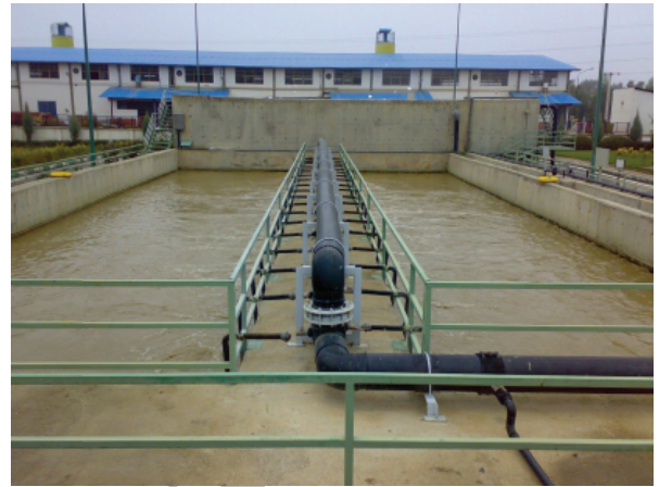
شکل ۱: واحد هوایی عمقی تصفیه خانه آق قلا
