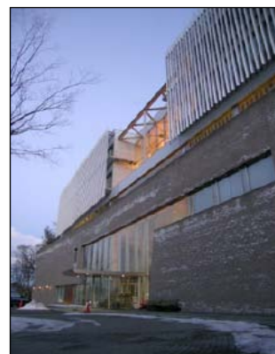
تصویر ۸. ساختمان GEC ماخذ : Levitt, Brendon 2005
