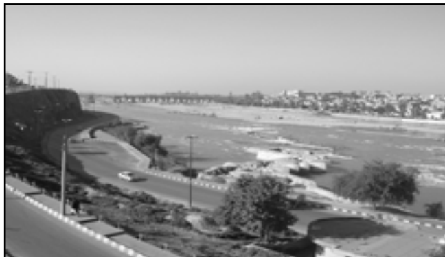
تصویر ۱. نمایی از کناره‌های بدون طراحی و آسیاب‌های در حال تخریب رودخانه دز - دزفول مأخذ: نگارندگان، ۱۳۸۸
