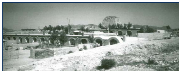
تصاویر ۳ و ۴. خانه‌های زیرزمینی منطقه loess در شمال چین، خانه به صورت گروهی در شکل‌های مختلف در اطراف یک حیاط قرار گرفته‌اند و با یک رامپ به سطح زمین متصل می‌شوند. در این منطقه نوع بازشوها متفاوت است و بازشوها بزرگ‌تر و متعددتر می‌باشند. حیاط با تمام المان‌های خود در پایین‌تر از سطح زمین قرار گرفته‌اند. مأخذ: Crouch, ohnson, 2001: 72
