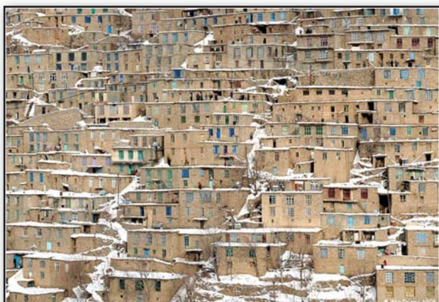
تصویر ۵. روستای اورامان کردستان. مأخذ : www.akkasee.com Fig5. Oraman Village in Iran's western Kurdistan province. Source: www.akkasee.com
