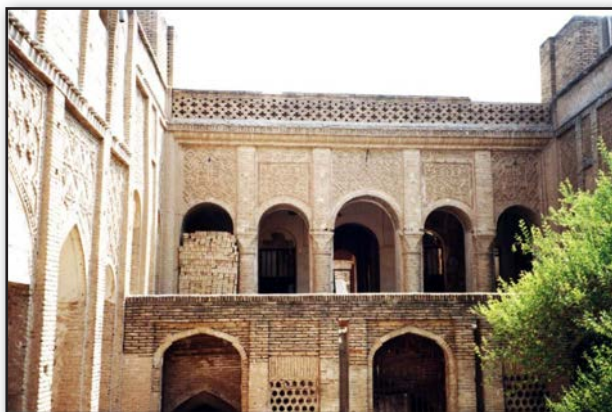
تصویر ۲. افزایش سطح سایه‌گیری جدارها در معماری سنتی دزفول با استفاده از طاق‌نماهای تزئینی. مأخذ: آرشیو محسن تابان.
