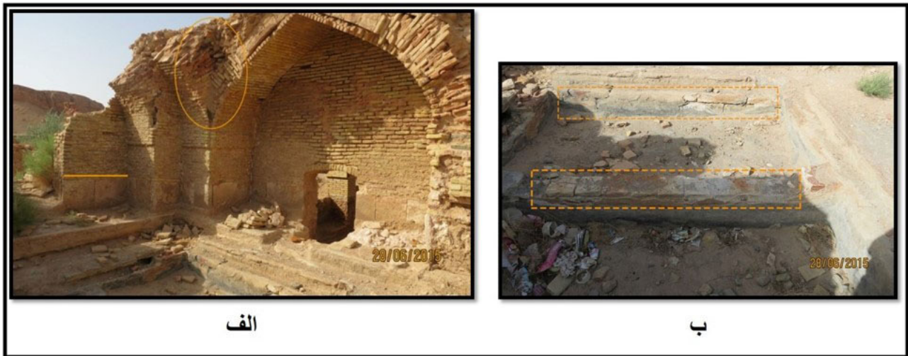
تصویر ۶. الف. حوضخانه دوره سلجوقی - فیلیپوش‌های متصل کننده گنبد و ازاره‌های سنگی. مأخذ: نگارندگان. ب. حوضچه سنگی مراد، ساخته شده از قطعات سنگ و مرمت شده با آجر. مأخذ: نگارندگان.
