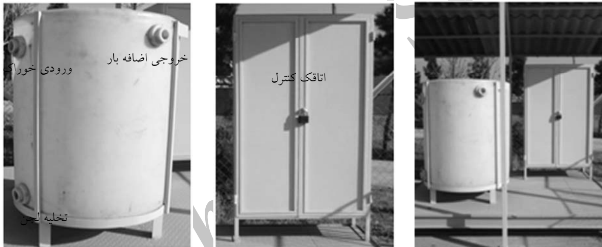
شکل ۳- تصویر مخزن هوادهی و اتاقک کنترل
