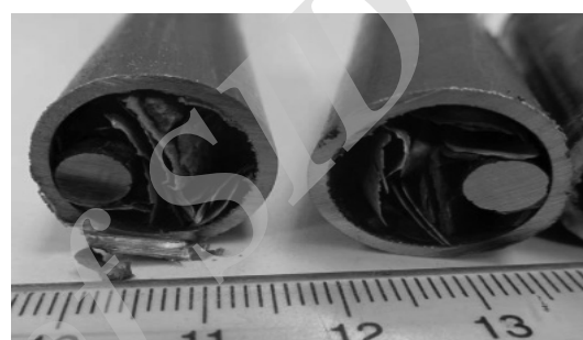
شکل ۲ تیوب تخریب شده به‌واسطه رسوب اجسام خارجی دچار گرفتگی شده است.
