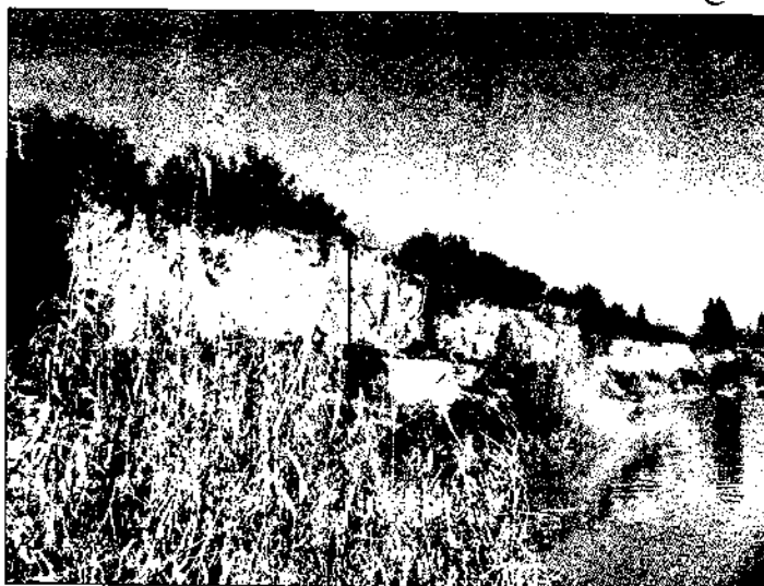
شکل ۸: میزان حفر بستر رودخانه تجن در نزدیکی ساحل (کارمیدانی ۱۳۸۶/۵/۲۰ فرح آباد، نگاه رو به شمال)
