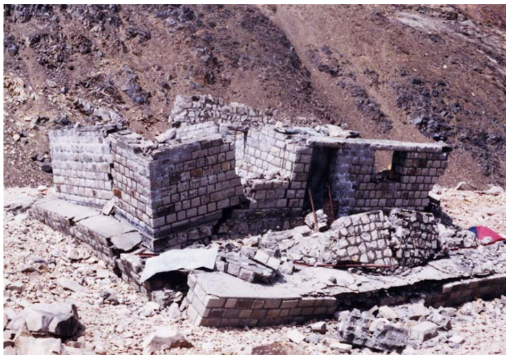
شکل ۲۳. تخریب پناهگاه علم‌چال به دلیل حرکت یخچال و ذوب سطحی یخ این عکس در سال ۱۳۷۹ گرفته شده است.
