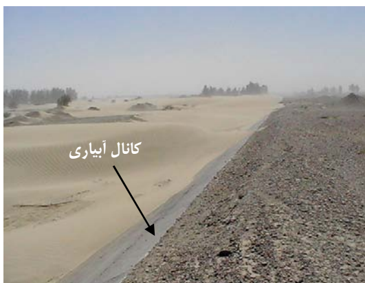
شکل ۳. پر شدن کانال‌های آبیاری سیمانی به طول چندین کیلومتر که بر اثر انباشت شن و ماسه غیرقابل استفاده شده‌اند
