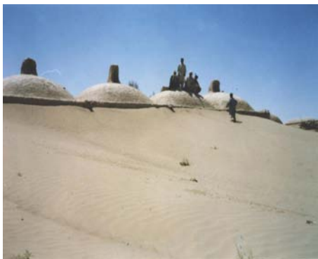
شکل ۲. مدفون شدن خانه‌های مسکونی در زیر رسوبات بادی با ارتفاع بیش از ۵ متر
