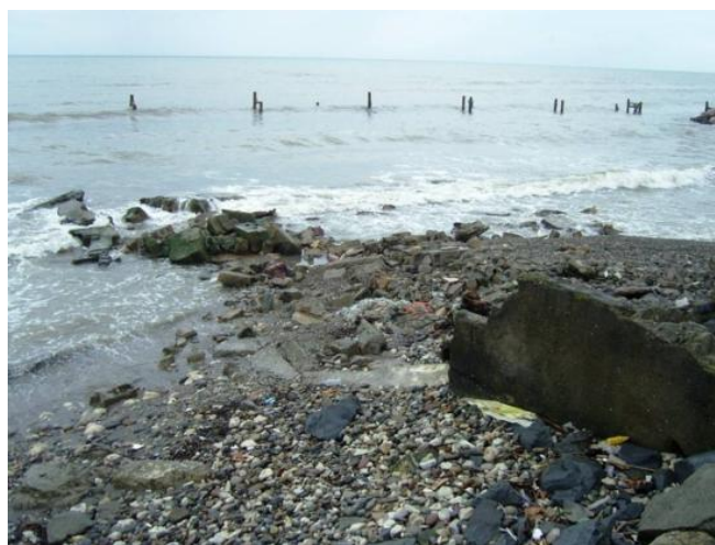
شکل ۱۴. پیش‌آمدگی آب دریا و تخریب بناهای مسکونی بتنی در ساحل چالوس (عکس از: قمری فتیده؛ ۱۳۹۲)
