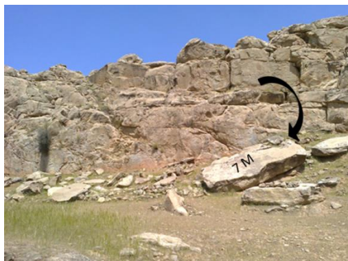
شکل ۵. وفور درزه‌های افقی، عمودی، و متقاطع در یک پرتگاه با ارتفاع تقریباً ۲۰ متری در لایه‌های سنگی سازند آغاچاری. این عامل سبب جدا شدن قطعه سنگی با طول ۷ متر (با فلش از نقطه‌ای که جدا شده نشان داده شده است) از دیواره صخره شده است که بر اثر حرکت واریزه‌ای از نوع چرخشی رخ داده است
