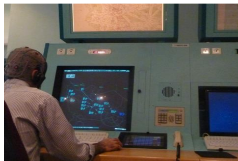
شکل ۱- ایستگاه کاری کنترلر ترافیک هوایی
