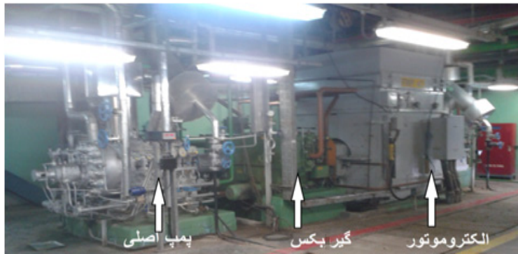
شکل ۱ - نمای کلی نمونه پمپ آب مورد بررسی
