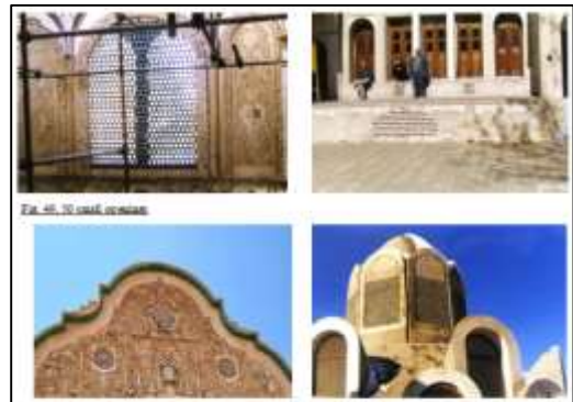
شکل ۲۳. کاشان- خانه بروجردی ها، روزنه های کوچک برای ورود و خروج هوا
