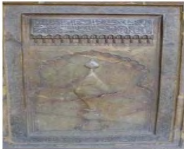
تصویر ۲: محراب سنگی ضلع شرقی مدخل ورودی گنبدخانه نظام‌الملک (منبع: نگارنده).
