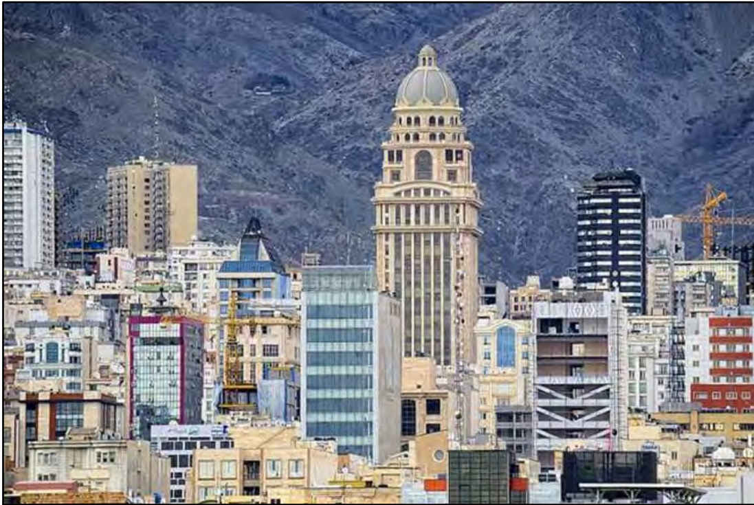
تصویر (۵) کیفیت و شمای کلی از نماهای ساختمان‌ها در منطقه یک شهر تهران (منبع: نگارنده).
