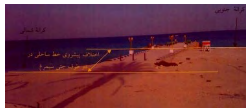
شکل ۱۱. (سمت راست)، نحوه رسوب گذاری در ساحل جنوبی اسکله هتل سیمرخ (منبع: مهندسین مشاور سازه پرداز، ۱۳۸۶)
