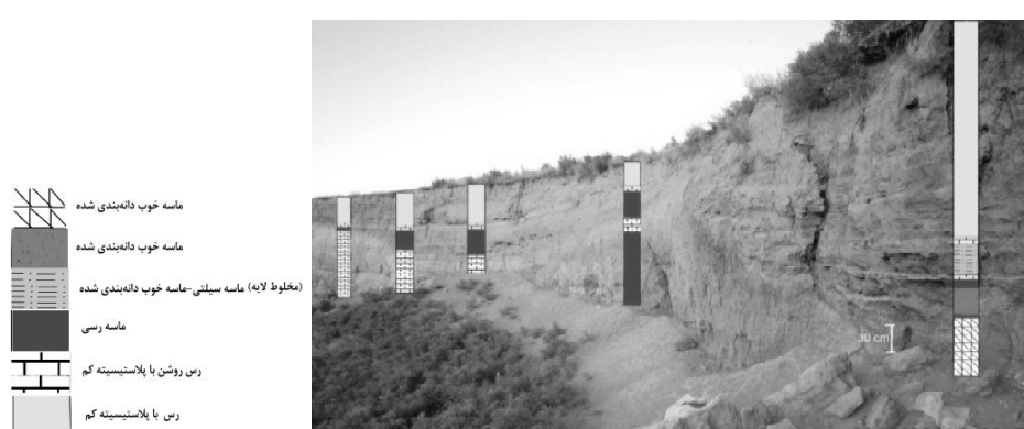
شکل 2. رخنمون دیواره لغزش و جنس لایه‌ها (بهزادتبار و همکاران، 1391)
