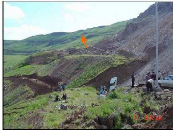
شکل ۱. نمایی از زمین لغزش گردنه صائین که تخریب جاده و سقوط خودرو را نشان می دهد (هاشمی طباطبائی، ۱۳۸۴).
