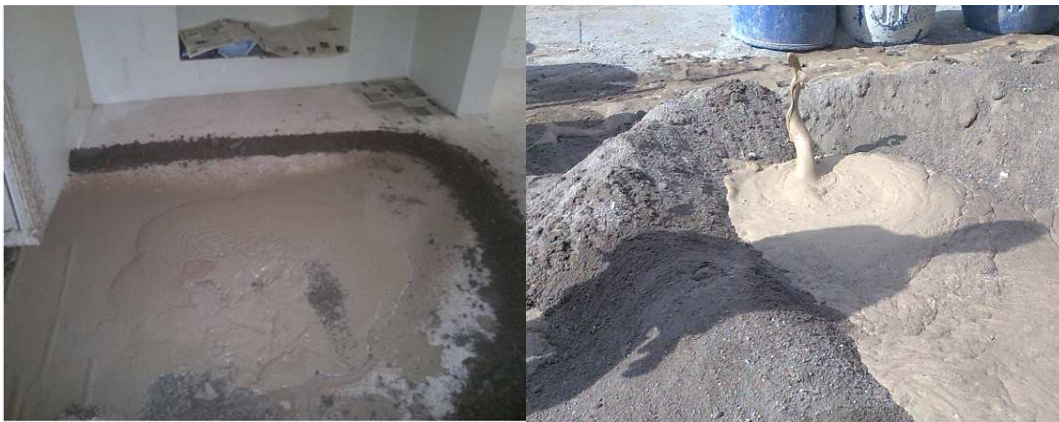
شکل ۱۲. نفوذ دوغاب بتونیت و خروج هوای تحت فشار به داخل منزل مسکونی در حین عملیات هایپرباریک (سمت چپ) خروج فوم از سطح خیابان در حین حفاری (سمت راست)
