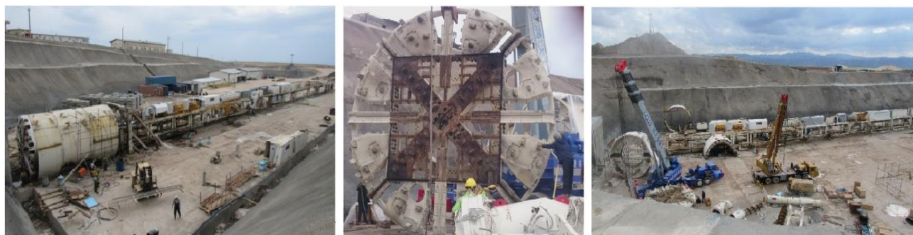
شکل ۴. مونتاژ سیستم پشتیبان و کله‌حفار ماشین پروژه بازی‌دراز.
