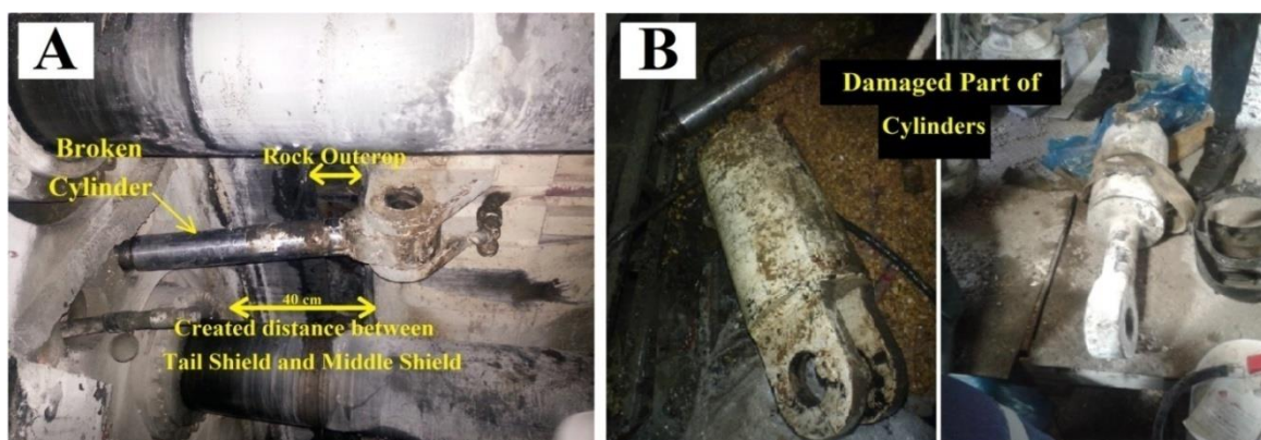
شکل ۲۱. A- نمایی از شکستگی جک مفصلی پسیو، فاصله ایجاد شده بین دو سپر میانی و انتهایی، رخنمون توده سنگ.
