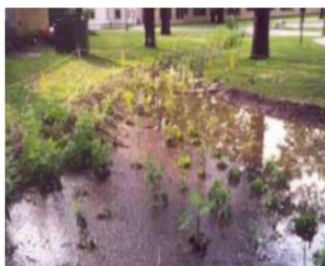
شکل ۵. حوضچه زیستی تازه کاشته شده پس از دریافت رواناب (طرح جامع مدیریت آب های سطحی تهران)
