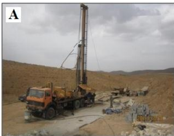
شکل ۸. A- عملیات حفاری چاه در موقعیت کیلومتراژ ۹+۴۷۰ بر روی محور تونل. B- لوله جدار چاه.
