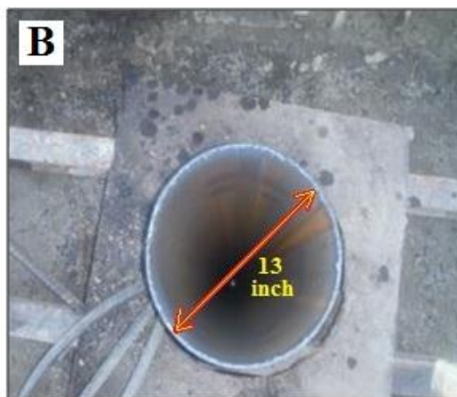
شکل ۸. A- عملیات حفاری چاه در موقعیت کیلومتراژ ۹+۴۷۰ بر روی محور تونل. B- لوله جدار چاه.
