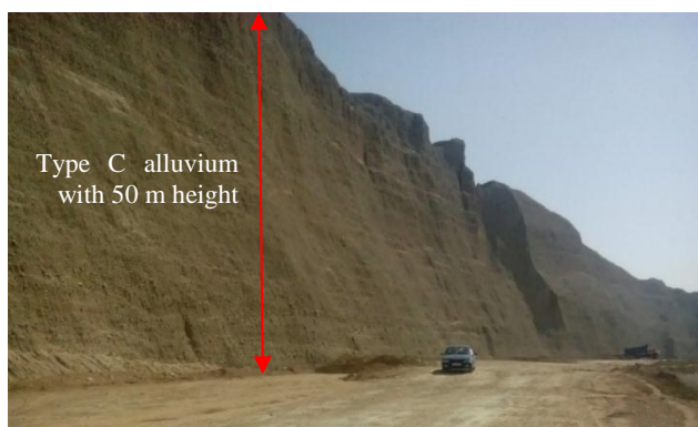
شکل ۱. دیواره شرقی گود حین عملیات پایدارسازی
