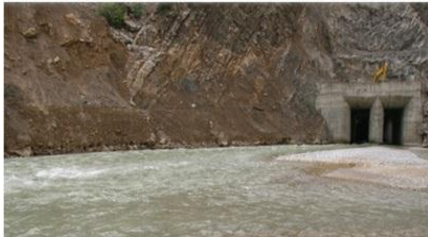
شکل ۳. قسمت ورودی تونل انحراف آب
