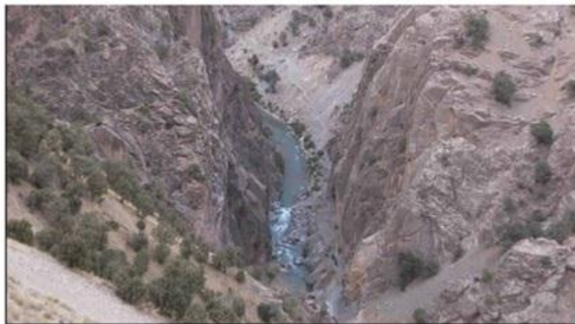
شکل ۲. نمایی از ساختگاه سد رودبار لرستان
