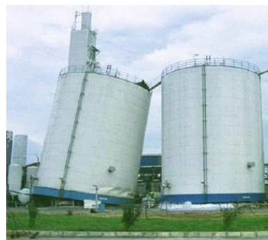
شکل ۵- (بالا) شمای کلی هندسه مخزن مورد مطالعه و (پایین) دو نمونه واقعی از مخزن مورد مطالعه متعلق به مجتمع هبس پس از زلزله ۱۹۹۹ ازبیت [۴]
