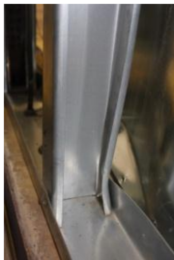
شکل ۵- کمانش موضعی ستونک
