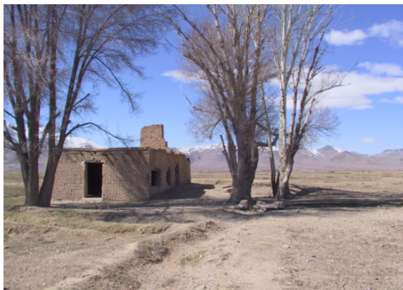
شکل ۱- نمایی از چاه‌های خشک شده و اراضی رها شده در منطقه
