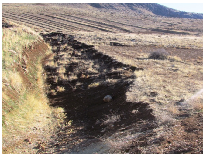
شکل ۲- تصاویر ریزش دیواره کانال‌های ذخیره آب
