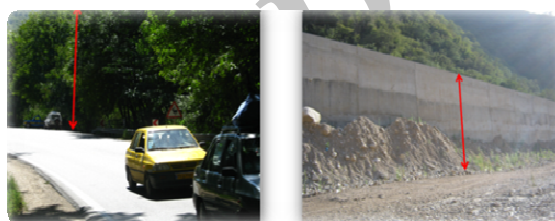
شکل ۳. ارتفاع موانع صوتی، مانع از جنس درخت (سمت چپ) و مانع از جنس بتن (سمت راست)
