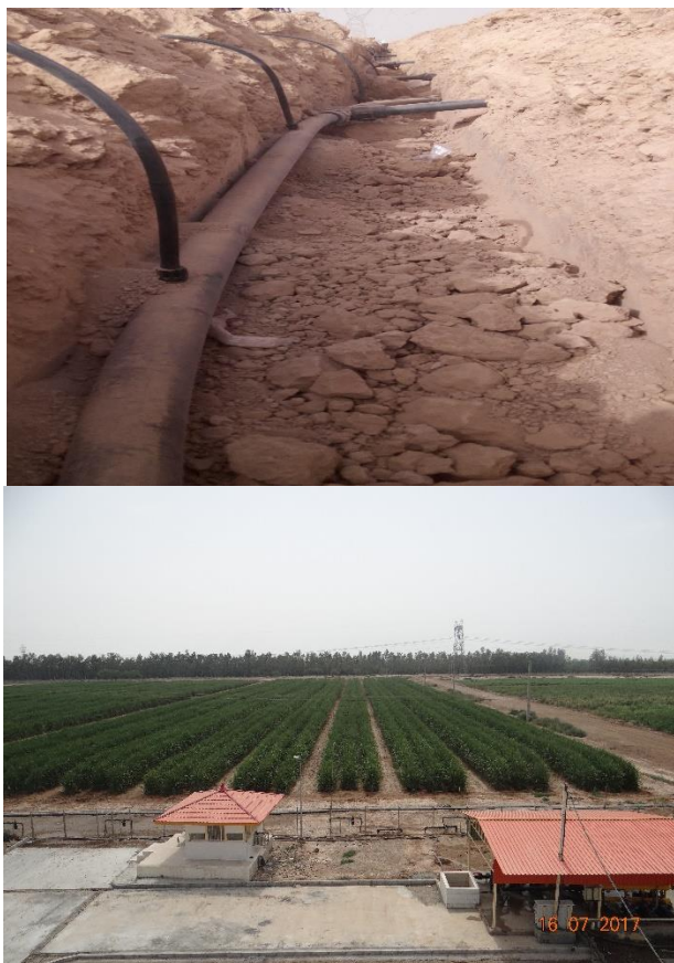
شکل ۲- بخشی از مزرعه آزمایشی و نحوه اتصال لوله آبد به مانیفولد در سامانه آبیاری قطره‌ای زیرسطحی
