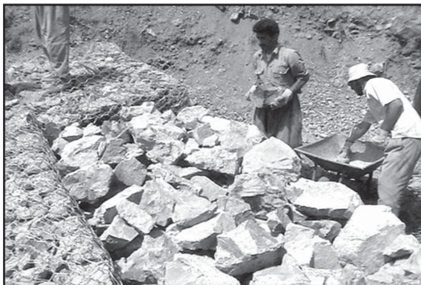
شکل ۱- تصویری از احداث سد توری سنگی در حوزه آبخیز حبله رود
