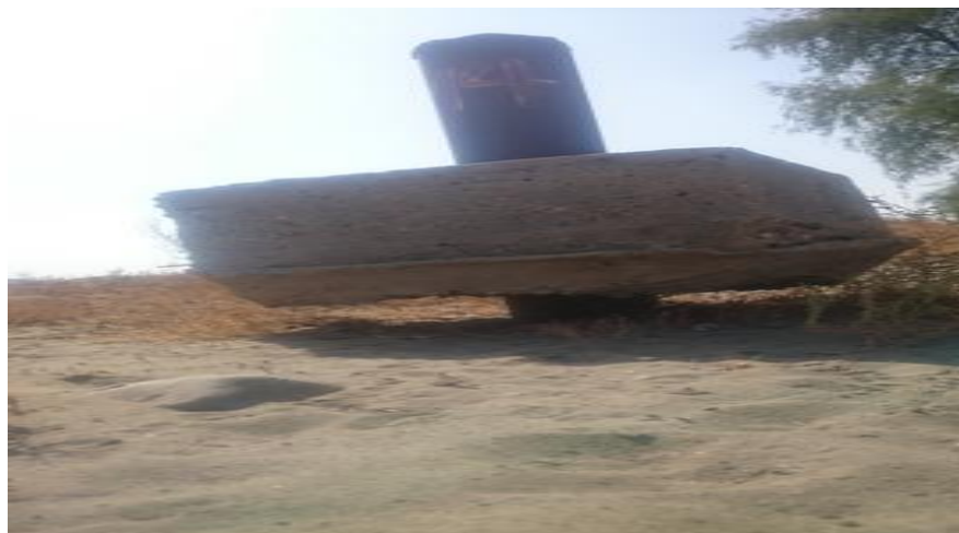
شکل ۹- بالا آمدگی چاه پیزومتری شماره ۱۴.
