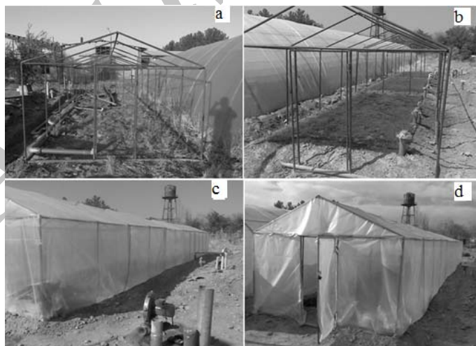
شکل ۲- مراحل ساخت گلخانه: (a) ساخت اسکلت گلخانه. (b) کشت چمن. (c and d) ایجاد پوشش پلاستیکی بر روی اسکلت و تکمیل ساختمان گلخانه
