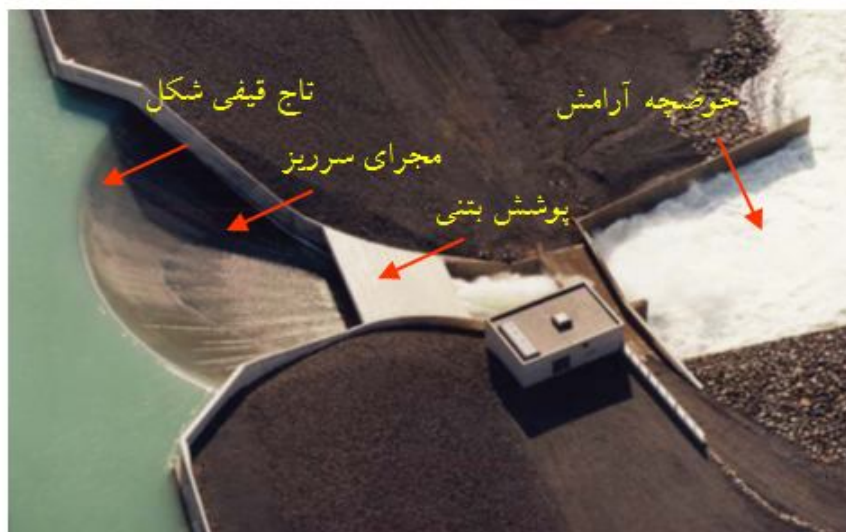
شکل 2- نمایی از سرریز قوسی سد واتن فال در زمان تخلیه سیلاب (طوفانی، 1392)
