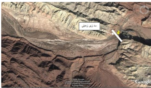
شکل 1- تصویر ماهواری از محل احداث سد و مخزن آن
