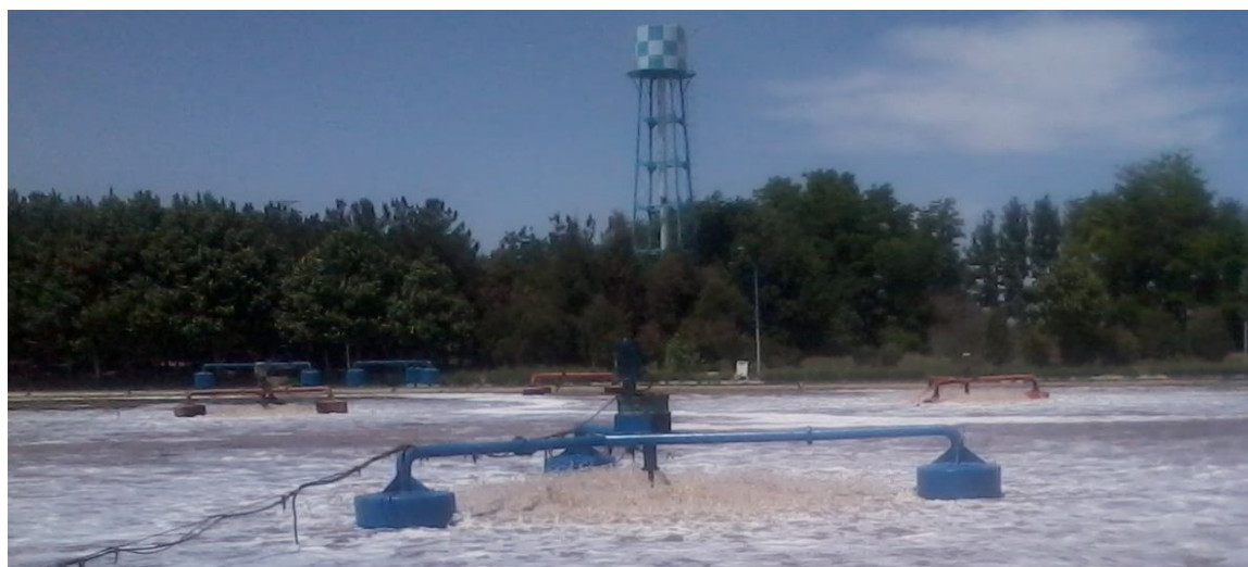
شکل 2- شماتیکی از هوادهی لاگون غربی تصفیه خانه پرکن‌آباد با استفاده از هوادهی سطحی دورکند
