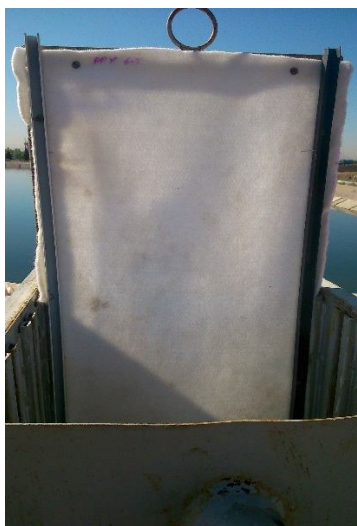
شکل 1- نصب و کارگذاری فیلتر ژئوتکستایل PPV 6.5
