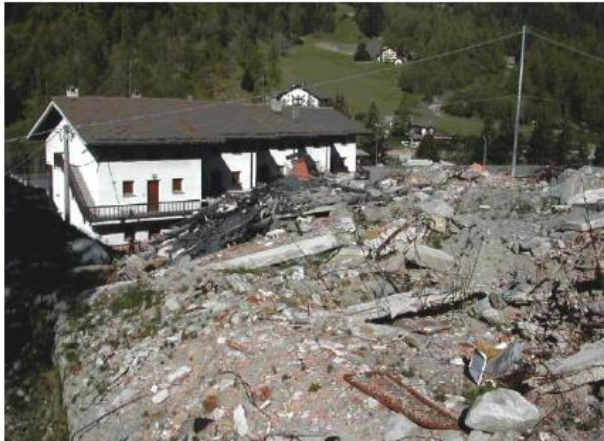
شکل ۱- تاثیر جریان واریزه‌ای بر روی یک ساختمان و تجمع واریزه‌ها پشت مانع شبکه‌ای انعطاف‌پذیر (Wendeler et al., 2008)
