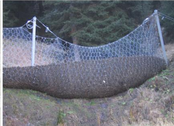
شکل ۱- تاثیر جریان واریزه‌ای بر روی یک ساختمان و تجمع واریزه‌ها پشت مانع شبکه‌ای انعطاف‌پذیر (Wendeler et al., 2008)
