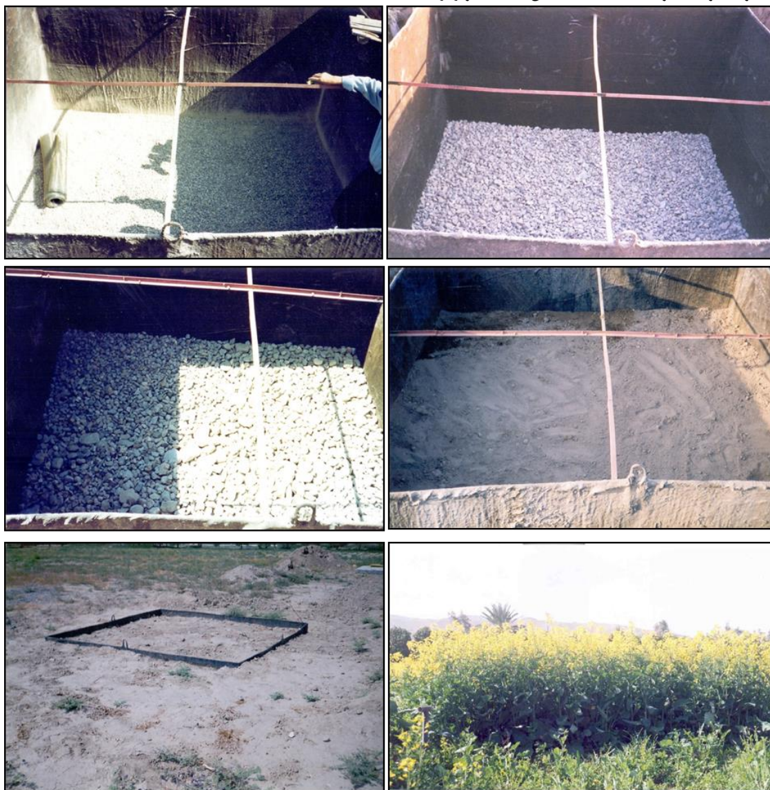
شکل ۲- مراحل نصب لایسیمتر در منطقه مورد آزمایش (حاجی آباد هرمزگان).
