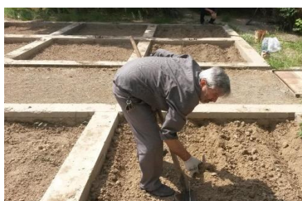
شکل ۲- آماده کردن زمین در زمان اضافه کردن پلیمرها
